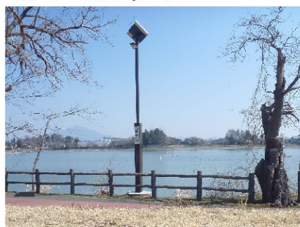
★LED照明灯設置施工例★
